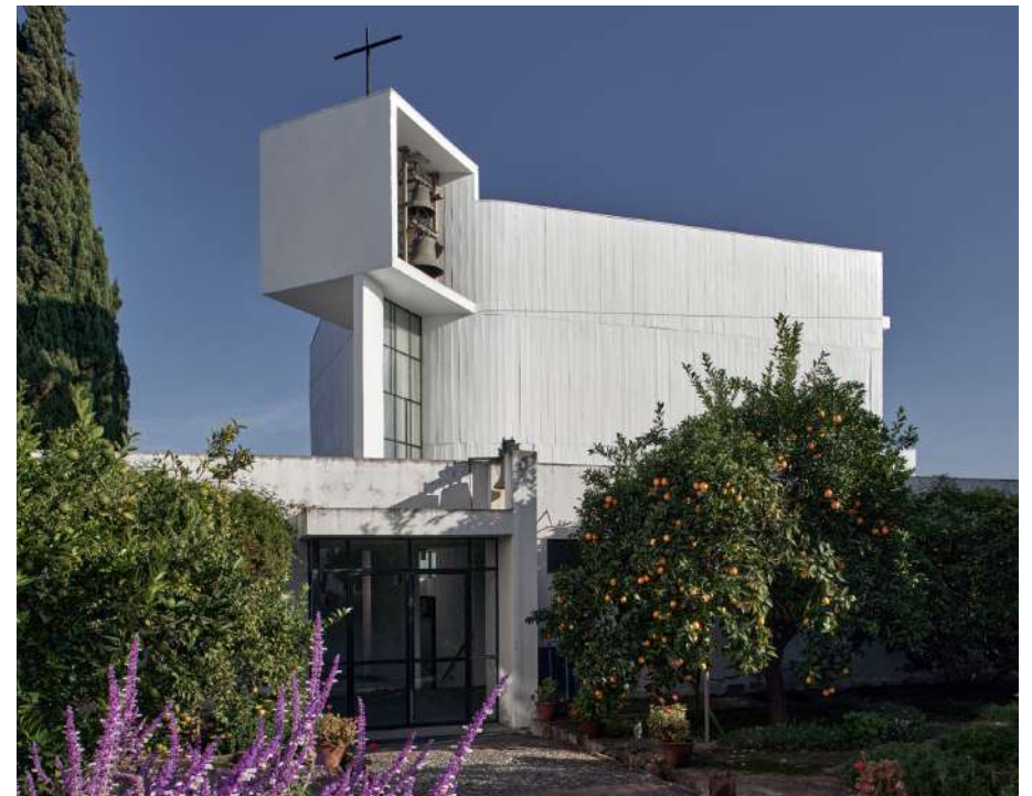
Figura 55: Fotografía fachada oriente de la iglesia del Monasterio de los Benedictinos terminada, 2023.
