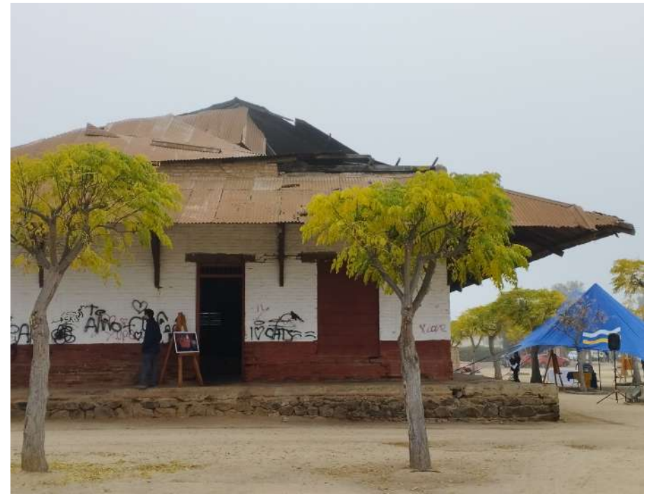
Figura 26: Fotografía exterior estado de conservación Ex estación Ferroviaria Catapilco, 2022.
