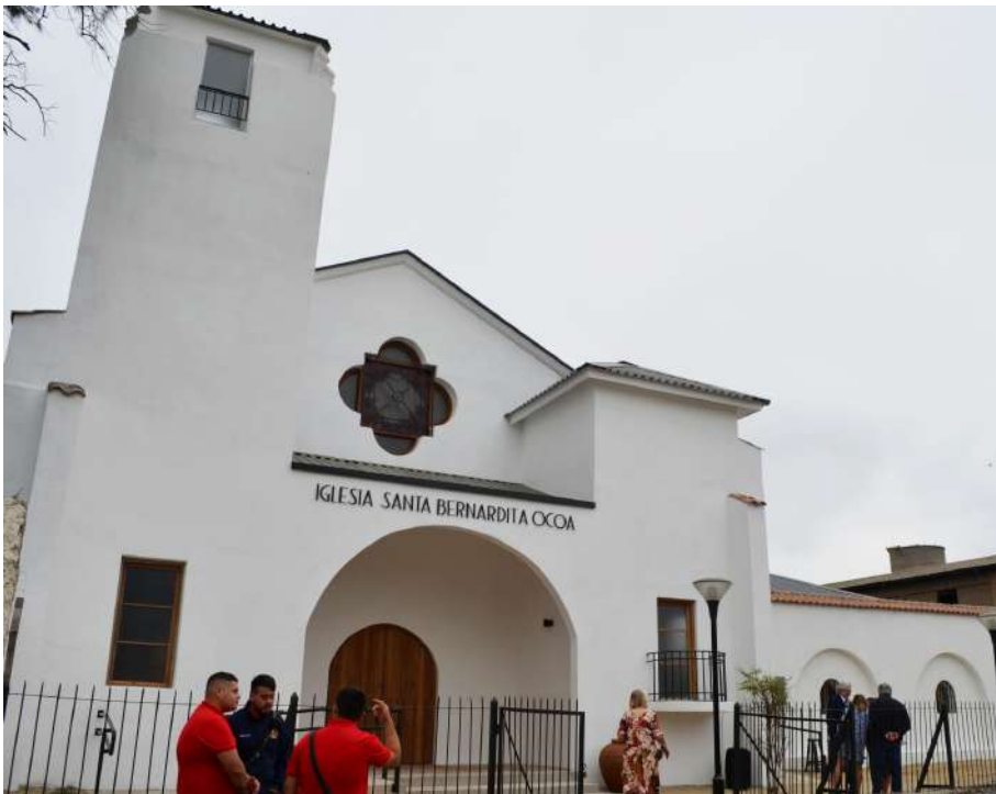
Figura 37: Fotografía fachada Iglesia Santa Bernardita restaurada, 2022.
