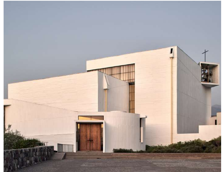
Figura 54: Fotografía fachada principal poniente de la iglesia del Monasterio de los Benedictinos terminada, 2023.
