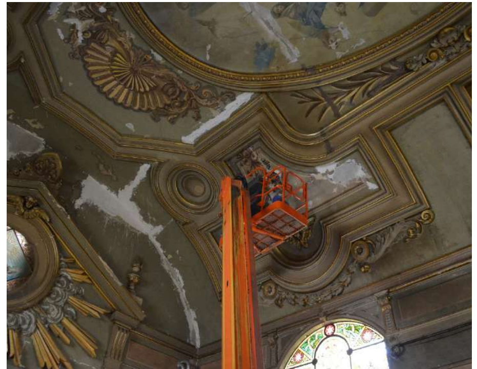
Figura 10: Fotografía restauración bóveda Catedral de Santiago.
