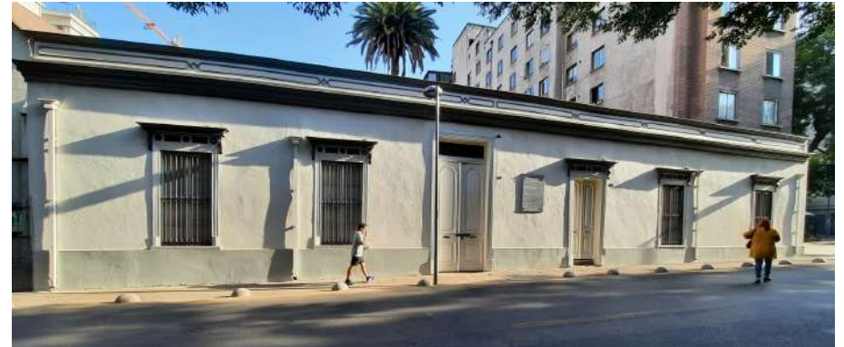
Figura 16: Fotografía fachada casa Santo Domingo restaurada, 2022.
