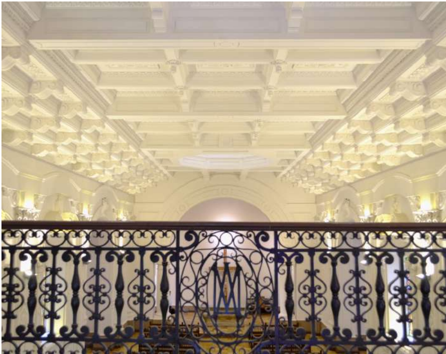
Figura 48: Fotografía cielo Iglesia Santa Lucrecia restaurada, 2014.
