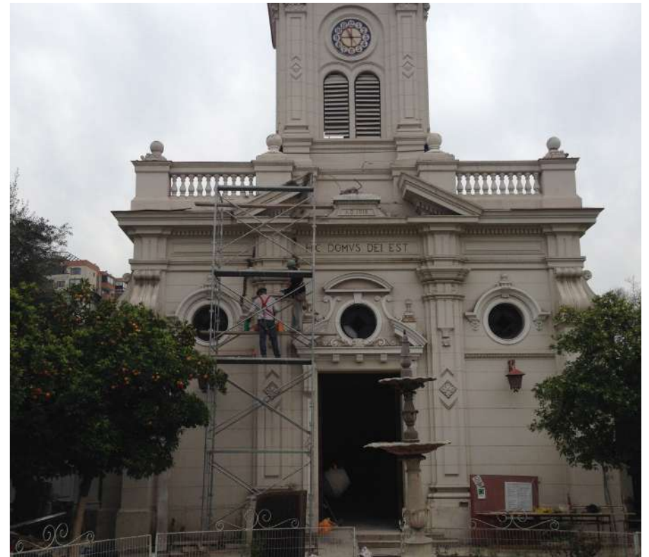
Figura 45: Fotografía trabajos de restauración fachada Iglesia Santa Lucrecia, 2014.
