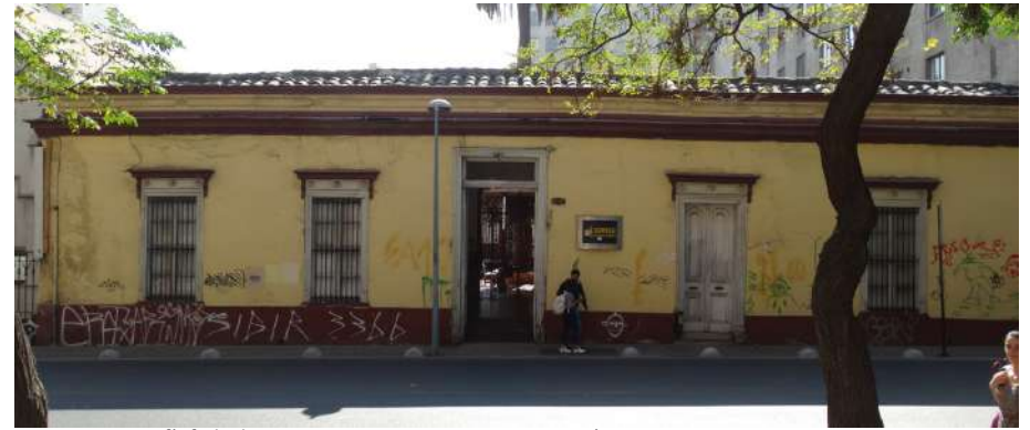
Figura 15: Fotografía fachada casa Santo Domingo previo a restauración, 2017.
