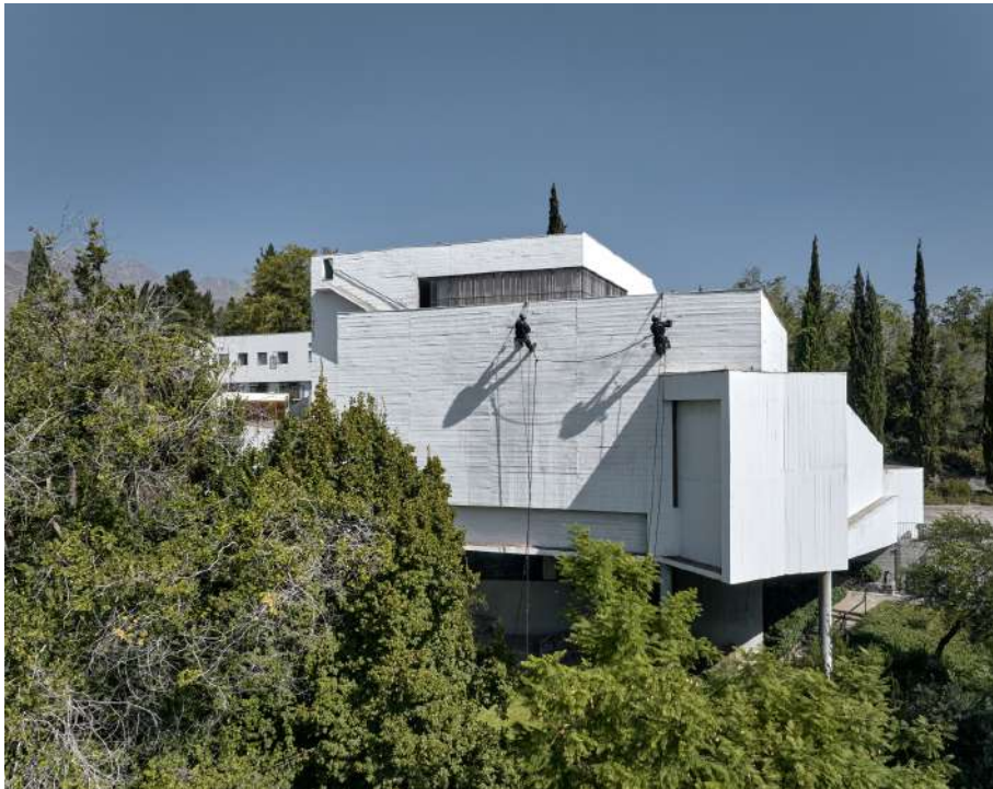
Figura 52: Fotografía proceso de hidro lavado fachada sur de la iglesia del Monasterio de los Benedictinos, 2023.
