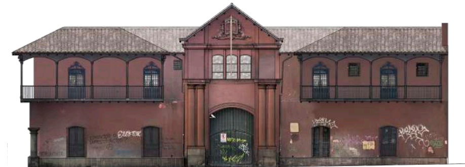
Figura 20: Ortofotografía estado casa Velasco previo a restauración, 2019.
